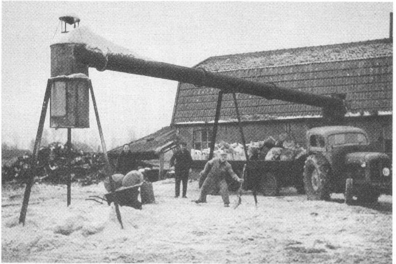
De houtsnippers (kif) worden door een lange pijp vanuit de klompenmakerij naar buiten afgevoerd. (collectie Wim Luimes)
